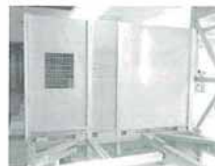
壁パネル組込み
