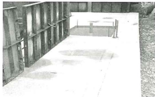
このウッドデッキの階段の下の板張りを撤去すれば段差解消機のコックピットが現れます。置くだけで良いので費用が少なくなります。
