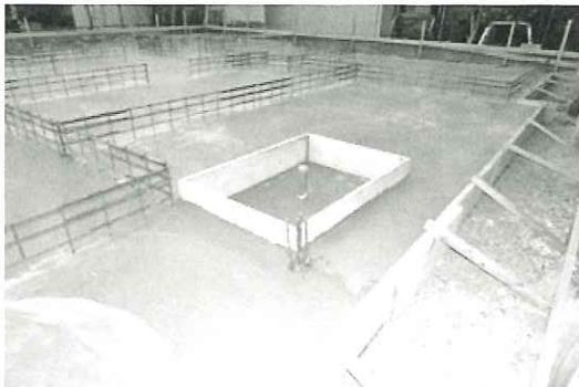
ウッドデッキのテラスに段差解消機コックピットが出来ていて、いつでも段差解消機が設置できます。
