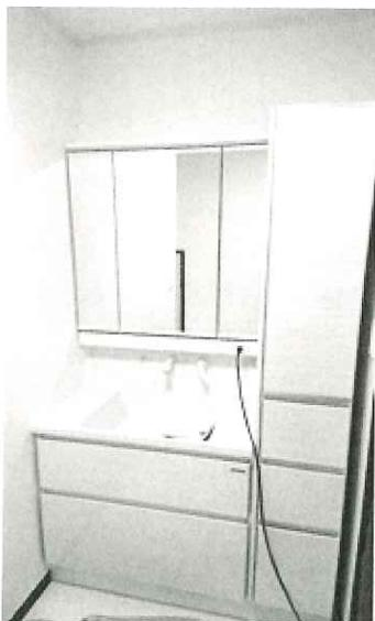
洗面所はクロス全面と、クッションフロアの貼替をし、洗面化粧台も新しく取替え、清掃性の高いものにしました。
