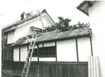
雨漏りしないように応急処置
