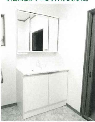
昔ながらのタイル貼り浴室、洗面室も1.5坪と広く寒いため、ヒートショックをおこしがちな寒い季節が心配、とのことで今回ご相談をいただきました。お住まいが鉄骨造りのため浴室の一角落には大きな柱がありましたが、話し合いの結果、柱部分が干渉しないひと回り小さなユニットバスを設置することになりました。併せて、浴室・洗面室共に、新たに天井・床・壁に断熱材を入れたので、外気温の変化を受けにくく、浴室暖房も設置しているので浴室と洗面室の温度差を抑えられ安心した生活が送れます。洗面台は鏡の裏に収納があるので片付けしやすく、下の収納には洗剤などのストックも置きやすいですね。N様からは『お風呂と洗面室が見違えるほどきれいになりました。段差もなくなりよかったです』とのお言葉をいただきました。
