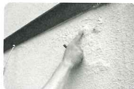
外壁の浮きやハガレをチェック。
