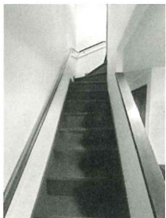
「寝室が2階にあり、階段の昇り降りが大変になってきたので、1階の和室をフローリングにしてそこを寝室にしたい」とのご相談でした。今回は、2間続きの和室の1室を天井や壁はそのまま、床部分のみ畳をフローリングに張替えとなり、照明はリモコンで操作できるものに取り替えました。あわせて、階段に手すりを取り付けたいとのご要望もありましたので、階段壁側に手すりを設置いたしました。Y様からは、「フローリングに張替えた部屋に早速ベッドを置いて寝ています。階段の手すりもこれまでより安全に昇り降りできるようになりました。リフォームしてよかったです!」とのお言葉をいただきました。
