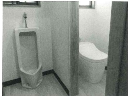
”キッチンが低いので使いづらく、扉も剥がれが見られるのでリフォームを検討している。併せてトイレもリフォームしたい。”とのご相談を頂きました。キッチンは、システムキッチンへリフォームし、天板は高さをこれまでより5cm上げ、使いづらさを解消。収納は開き戸から引出し式になったことで、屈まず物が取り出しやすく、収納力もアップ。様々な調理器具も収納することができるようになりました。そのため高い位置にある吊り戸は無くなり、キッチン全体がすっきりとした印象となりました。トイレはクロスの剥がれの他に下地が傷んでいるところもあったので補修を行い、壁・天井のクロスと床のクッションフロアを張替え、便器は隅付タンクトイレから Panasonic のタンクレストイレに取り替えました。S様より「キッチンが高くなったので使いやすくなりました。いまはどこに何を収納するか思案中です。トイレもきれいになりとてもよかったです」とお言葉を頂きました。
