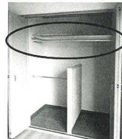
和室を洋室改修したいとご相談を頂きました。床にベッドを置くので、畳からフローリングにしたいとのことでしたので、畳を外し床下の高さ調整を行い、フローリングを施工。壁は元々クロスでしたので、貼替えを行い、襖は壁のクロスと同じ柄で統一し、引手を取替えました。クローゼットは枕棚が高く使いづらかったので、使いやすい高さに変えました。
