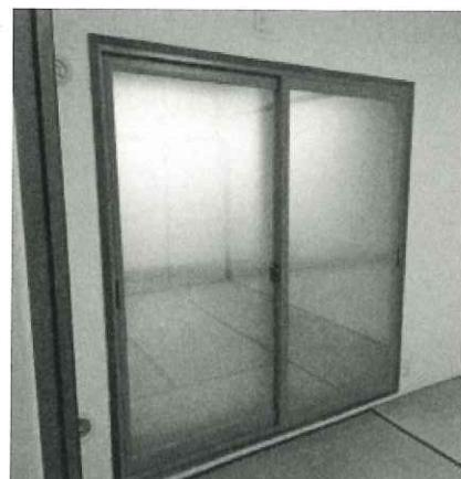
マンションへの引っ越しを機にリフォームをしたい、とのご相談を受けました。築 29 年のマンションという事もあり既存の窓はすべて単板ガラスでしたので、寒さ対策として窓リノベ事業の補助金を活用し、窓のリフォームを行いました。マンションは、規定で外窓を取り替えることが出来ないため、今回、内窓を設置することを選択いたしました。外部に接する窓6ヶ所すべてに内窓を取り付けたことで、寒さが軽減されました。和室の窓は既存の障子があったため、障子を外してその部分に摺りガラスタイルの内窓を施工することで目隠しにもなり、障子と同様の効果も得られます。マンションは戸建て住宅に比べて気密性が高いので、内窓を設置しただけでも大きな断熱効果を得ることが出来ます。Y 様からも「部屋が寒くなったり、エアコンの効きも非常によくなりました。」とのお言葉をいただきました。内窓は断熱に加え、防音、防犯にもなり、断熱性が上がることで、節電にも繋がります。今年も窓リノベ事業の補助金がございますので、気になられる方はぜひご相談ください。
