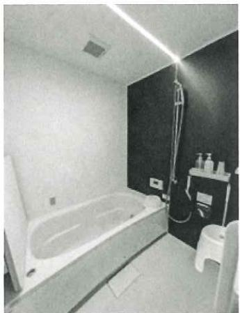
「浴室の寒さが気になるので改善したい」とご相談をいただきました。浴室が少し広めの 1.25 坪のタイル張りだったので、冬場はかなり寒かったと思われます。今回はユニットバス化に伴い、断熱性を重視し、基礎と壁面に断熱材を貼り、窓は塞ぐことにしました。ユニットバスは気密性が高いので、窓を開けて換気するよりも、浴室ドアを締め切って換気扇を回した方が早く乾かすことが出来ます。
