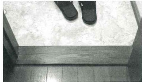
「トイレから水漏れしている」とのことでのご相談があり、確認させていただくと、既にメーカー修理の対応が出来ない製品でしたので、トイレ取替えをご提案させていただきました。今回は使いやすさも考え、フタの自動開閉と、自動洗浄機能がついたPanasonicアラウーノを設置いたしました。併せて、「廊下とトイレの間の敷居が6cm程ある為、今後の事を考えると、つまづくりスクも高いので撤去できないか」とのことでしたので、敷居を撤去し、段差を解消しました。敷居がなくなったことによってできた隙間は、ドアの下部に部材を継ぎ足し調整しました。家の中の段差は転倒のリスクがあるので、なるべく無くして安全に過ごしたいものですね。ドア(建具)の動きの調整なども行っておりますので、ぜひご相談ください。M様より「トイレが自動でなんでもしてくれるようになり、まだ慣れないけど助かっています」とお言葉をいただききました。
